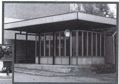
AUTOBUSOVÁ ZASTÁVKA na náměstí vedle domu č.p. 8
