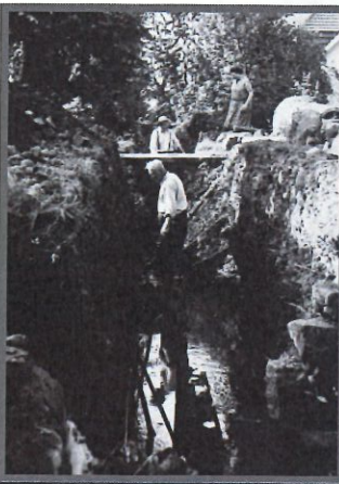
ZATRUBŇOVÁNÍ PŘÍKOPŮ v Nádražní ulici
