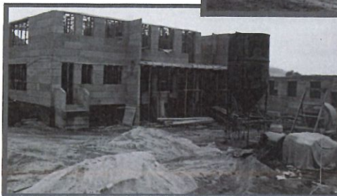
VÝSTAVBA MATEŘSKÉ ŠKOLY
