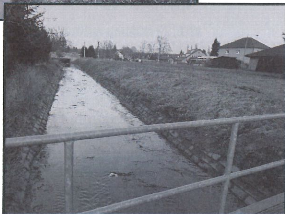
Po vyčištění potoka je vidět zpevněné břehy, byla upravena i prorůstající náletová vegetace
